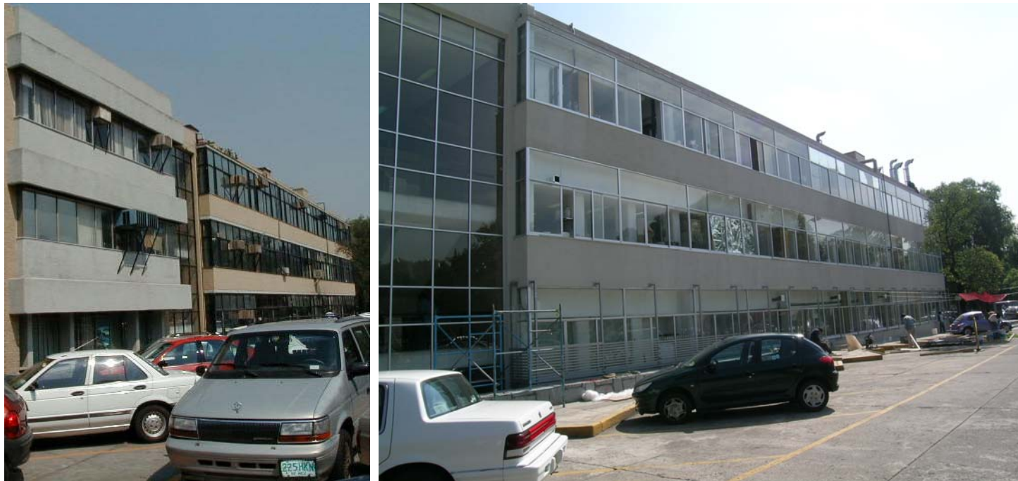
Los trabajos de remodelación de la fachada principal de Biomédicas han dignificado la sede que aloja a la dependencia desde 1954. A la izquierda se observa el aspecto que guardaba el edificio al iniciar los trabajos. A la derecha, se aprecia el cambio de los acabados, que serán rematados con parasoles metálicos.
