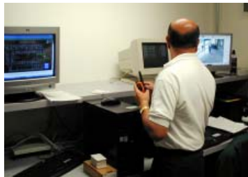
Sistema de vigilancia por circuito cerrado de televisión.
